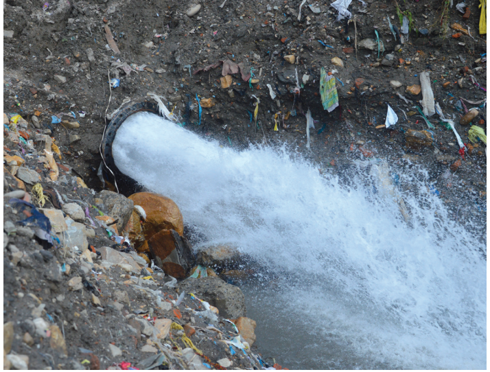
■ मेलम्ची आयोजना अन्तर्गत बिछ्याइएको थोक वितरण प्रणाली अन्तर्गतका पाइपलाइनको सफाइ खरिँदै ।
